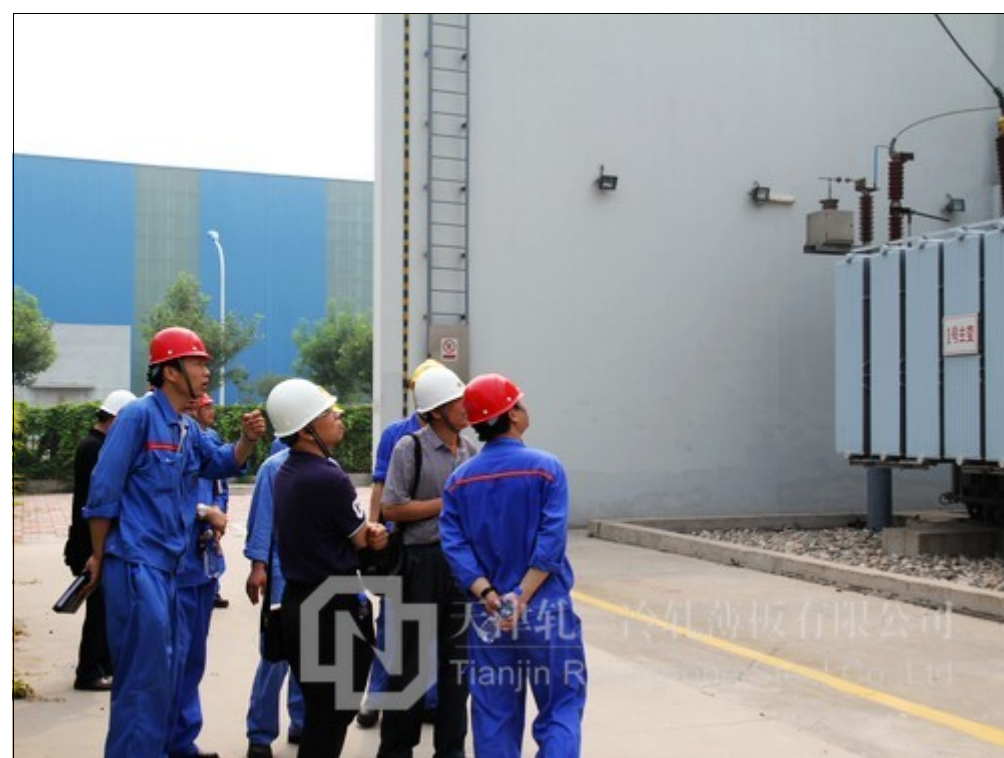
渤海钢铁集团领导到电站现场检查安全
